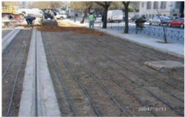
**Système d'arrosage enterré par la technique de sub-irrigation**
