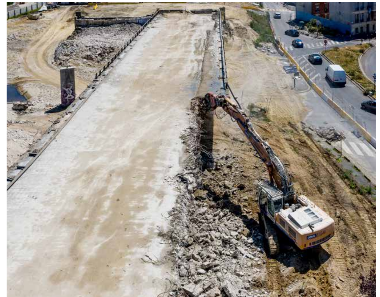
Démolition d'un ouvrage de l'ex-A186
